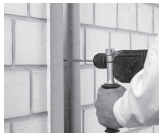
Fixation des montants à un mur massif avec interposition de bandes isolantes
