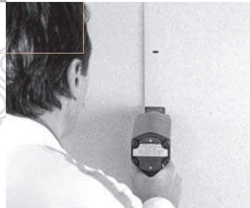
Agrafage FERMACELL sur FERMACELL
