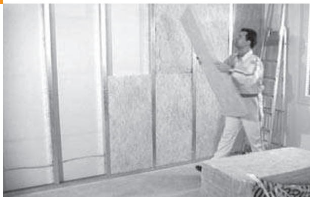
Pose de plaques isolantes
