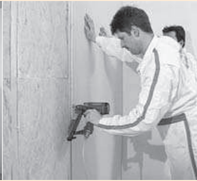
Pose d'un parement sur une ossature bois (ici à l'aide d'agrafes)
