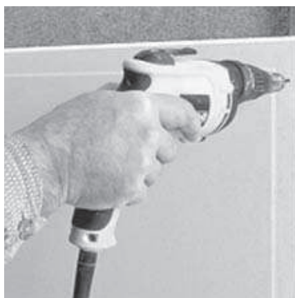
Vissage sur une ossature métallique
