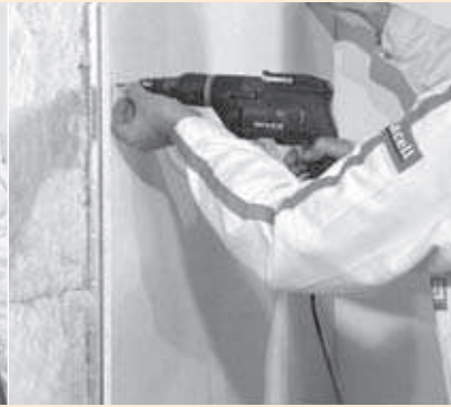
Fixation du parement par vis autoperceuses
