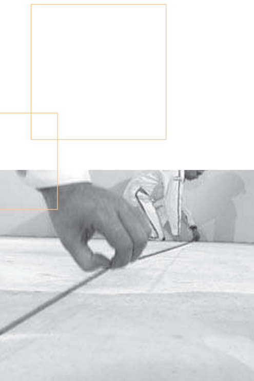
Tracer l'axe de la paroi avec un cordeau à tracer ou un niveau laser
