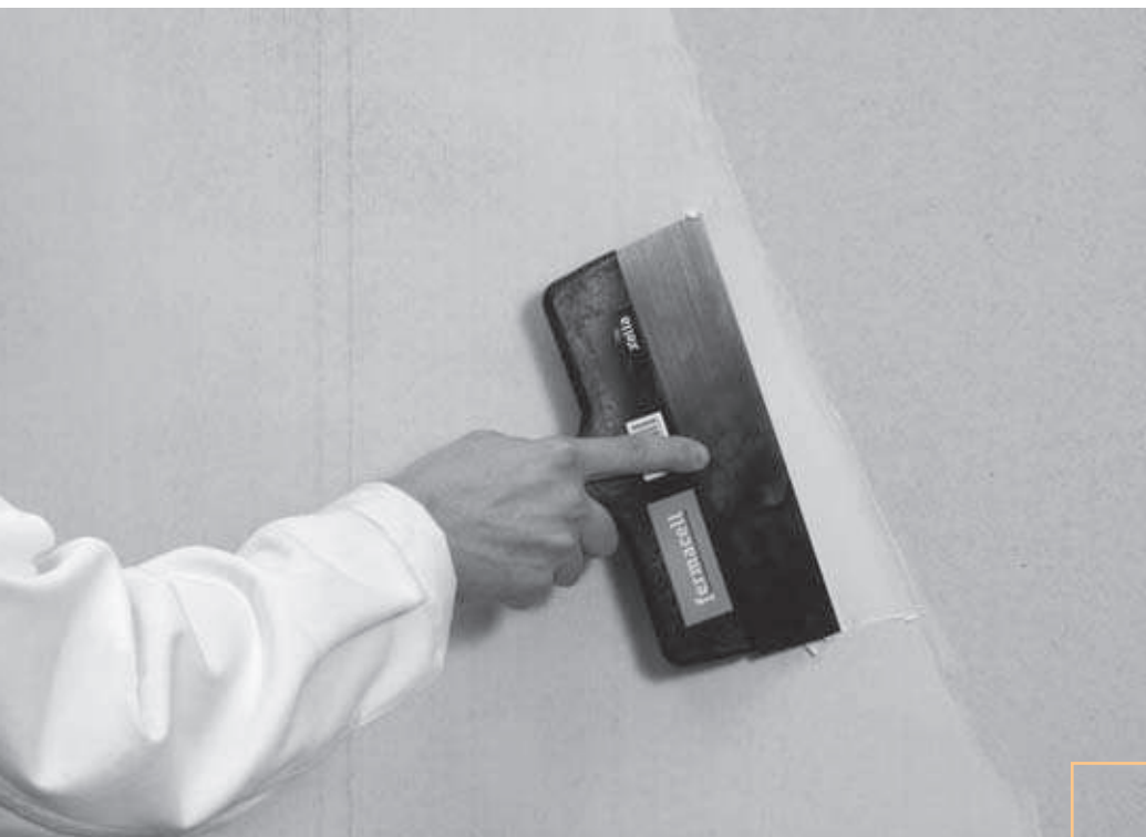
Surfaçage d'une plaque FERMACELL
