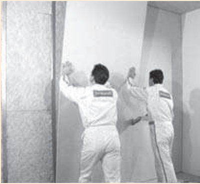
Pose d'un parement sur une ossature métallique
