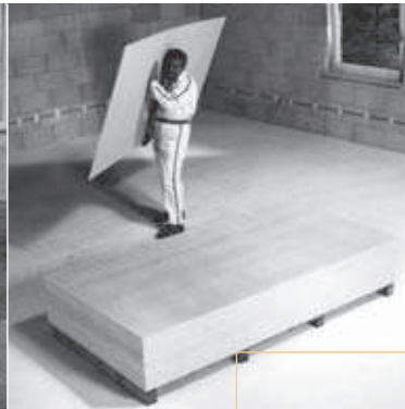
Une plaque FERMACELL se transporte sur chant
