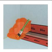
Coller ensuite la Bande d'étanchéité **fermacell** sur tous les angles et raccords de la douche avec l'Etanchéité liquide **fermacell**.
