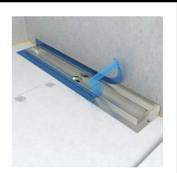
Coller le ruban isolant butyle sur le caniveau et la douche à l'italienne et presser sans bulles ni plis ...
