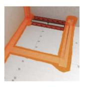
Recouvrir la totalité de la surface de la Douche à l'italienne en appliquant 2 couches d'Etanchéité liquide **fermacell**.
