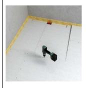
Au bout de 24 heures, racler les excédents de colle (par exemple avec un Couteau à colle **fermacell**) et enduire les têtes de vis sur la surface de la douche à l'italienne avec l'Enduit de lissage **fermacell** Powerpanel.
